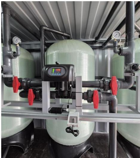
Para el diseño de un filtro abatidor de hierro y manganeseo se requiere contar con un análisis de laboratorio al agua a tratar de acuerdo con la norma chilena 409 de 2005, para conocer los valores de hierro y manganeseo presentes en el agua y así definir su tamaño y se requiere tratamientos adicionales.
