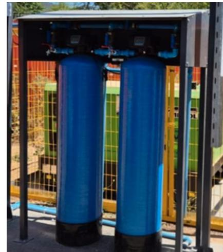
El proceso de filtración se lleva a cabo mediante el paso del agua a través del lecho a un caudal y una presión determinada, estas condiciones definen el tamaño del filtro a elegir.
